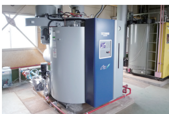
高効率タイプのボイラーへ更新
